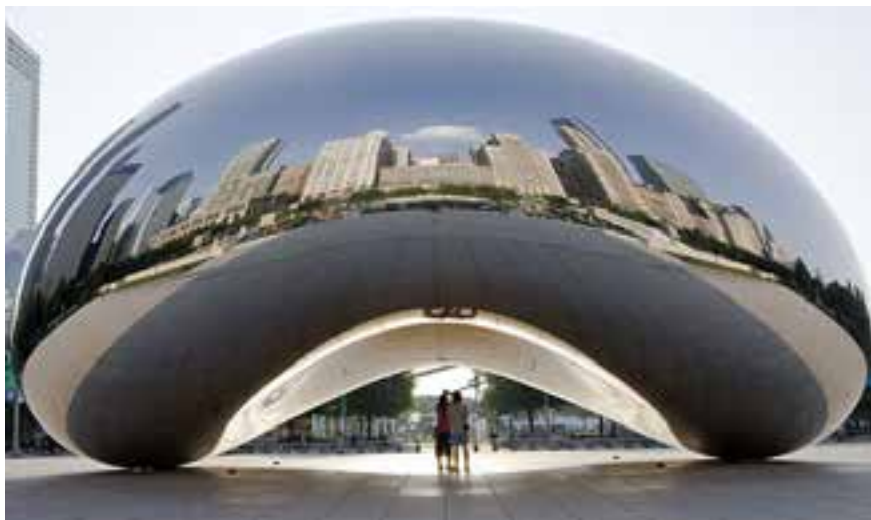
Escultura “Cloud Gate”, de Ansh Kapoor, instalada na cidade Chicago, nos EUA: 168 placas de aço inoxidável, 13 metros de altura, 20 metros de comprimento e 10 de profundidade e 99, 5 toneladas
